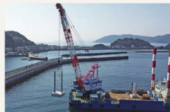
基盤ブロックの設置状況
