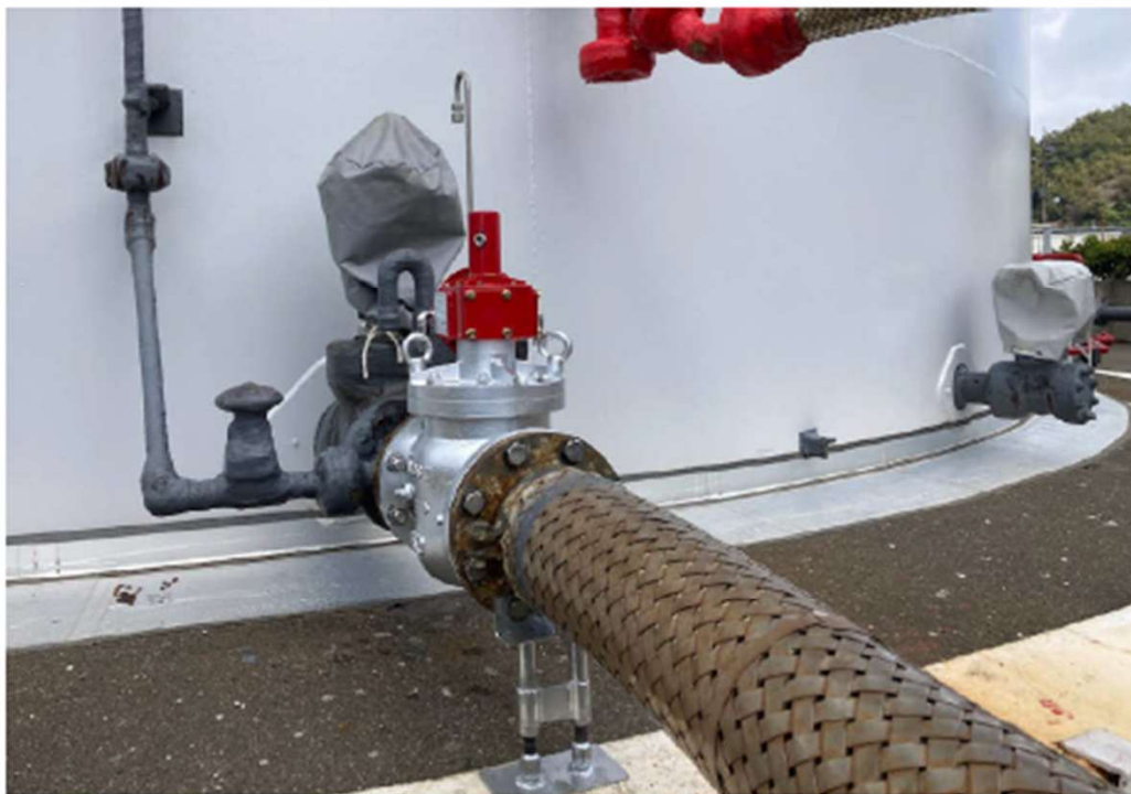
② 東京電力パワーグリッド(株) 父島内燃力発電所 900kL A重油タンクの 150A 浸感弁
