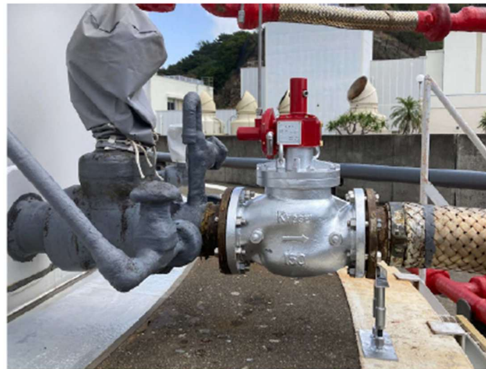
② 東京電力パワーグリッド(株) 父島内燃力発電所 900kL A重油タンクの 150A 浸感弁
