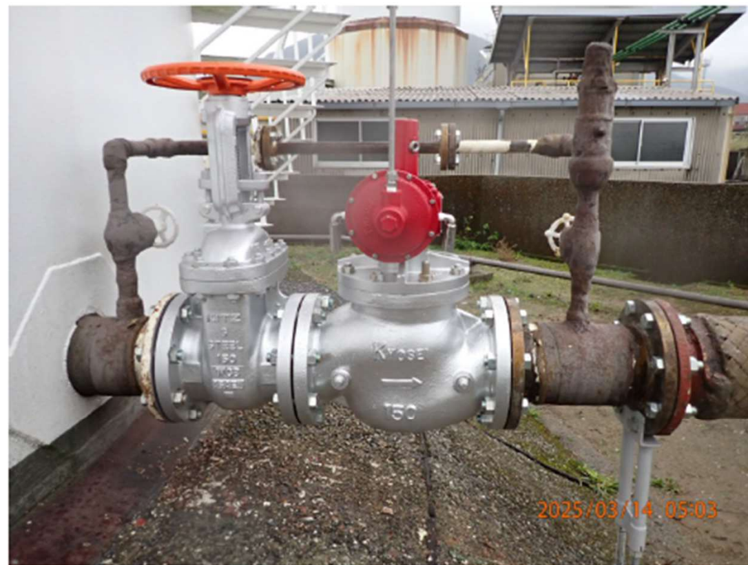
① 日米ユナイテッド株式会社屋久島油槽所 260kL ガソリンタンクの 150A 浸感弁
