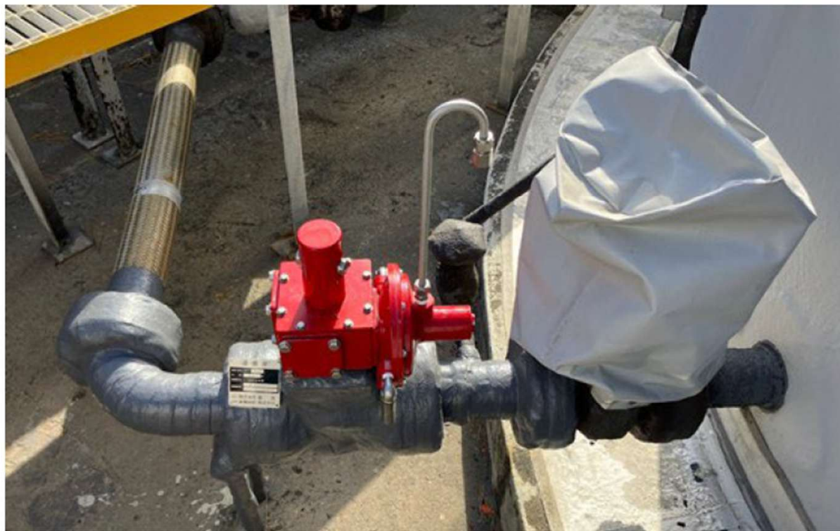
④ 東京電力パワーグリッド(株) 新島内燃力発電所 100kL A重油タンクの80A 浸感弁
