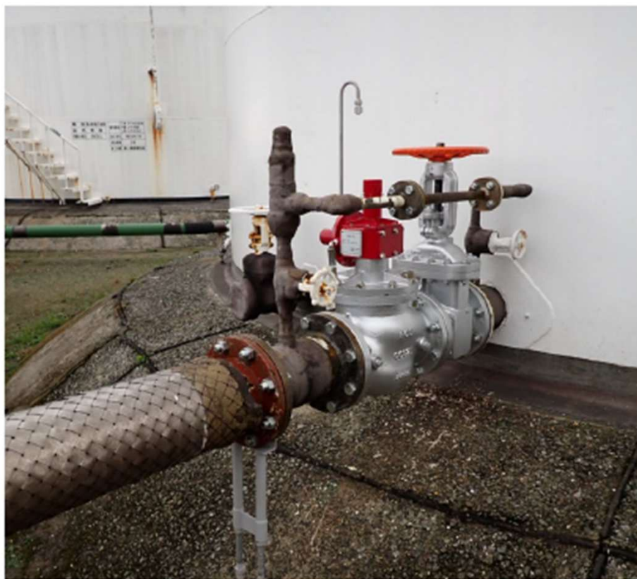
① 日米ユナイテッド株式会社屋久島油槽所 260kL ガソリンタンクの 150A 浸感弁
