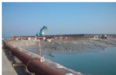
陸上配管状況
