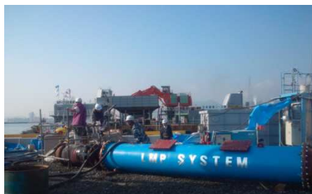
LMP工法によるセメント添加
