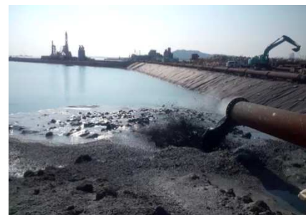
埋立状況（配管からの吐出）
