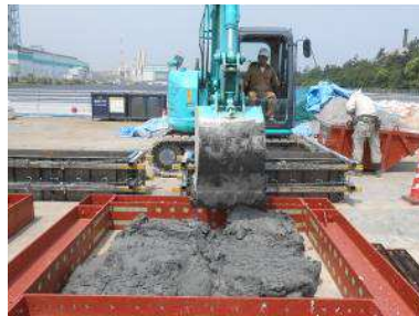
型枠への打設
