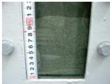
分級装置内砂堆積状況
